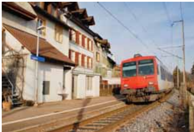
Bei Ligerz fährt die Eisenbahn so nahe an den Häusern vorbei, dass die Anwohnerschaft Lärm ausgesetzt ist. Bild: René Villars/a
