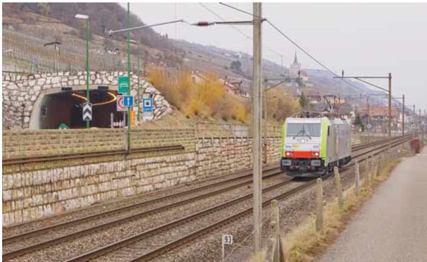
In diesem Bereich, kurz vor Ligerz, sollen die Züge dereinst in einen Tunnel einbiegen.
