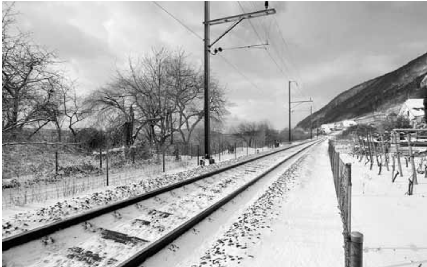
Die Einspurstrecke durch Ligerz kommt mit täglich 250 Zügen an ihre Kapazitätsgrenzen.
